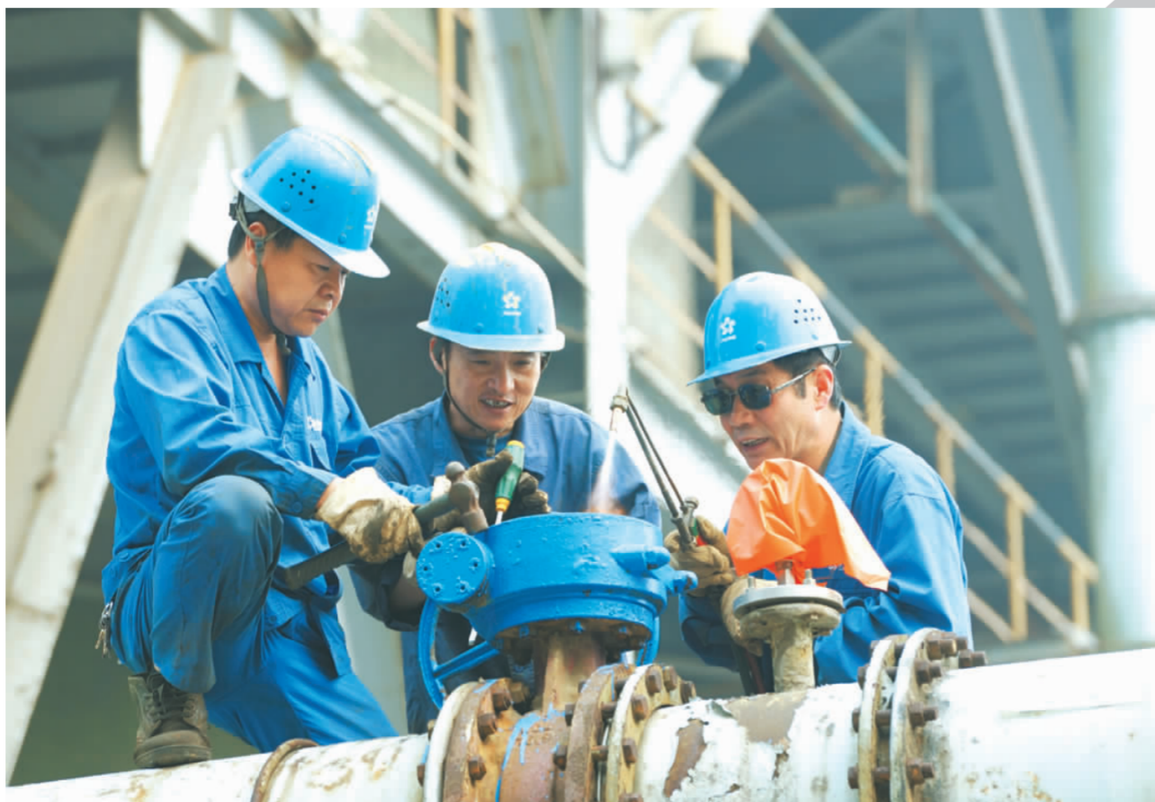
▼5月20日，硫酸车间职工正在塔架上进行维修作业。
