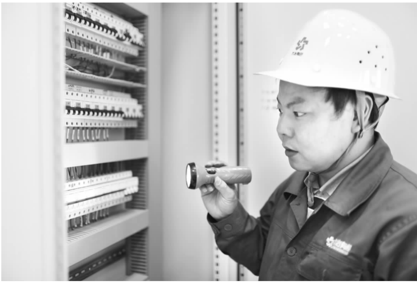
▲侯帮炬在检查电气线路
