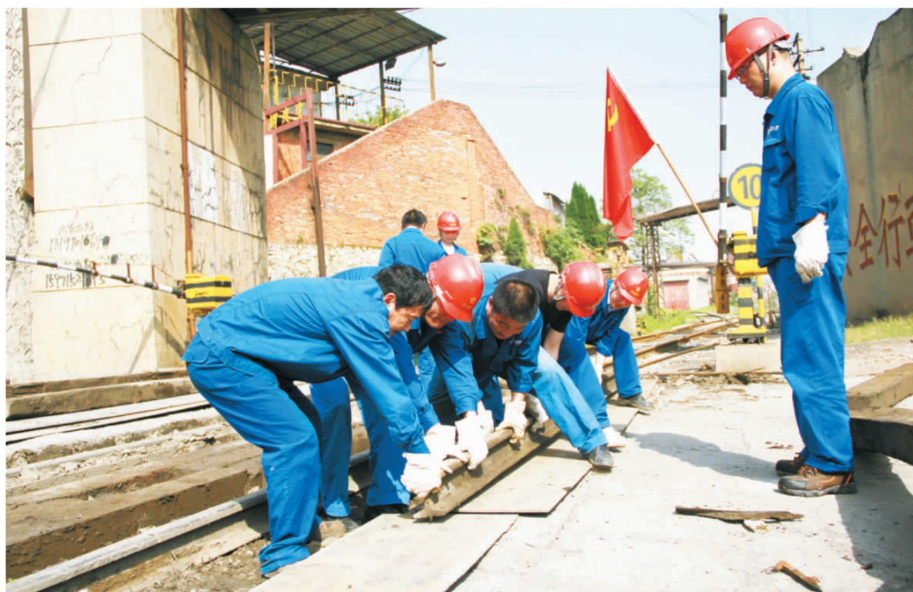
▲5月9日,铜绿山矿运输车间组织党员突击队队员和养路班的职工对四道道口进行抢修。图为党员和职工们正在搬运铁板。梅晓艳 摄
