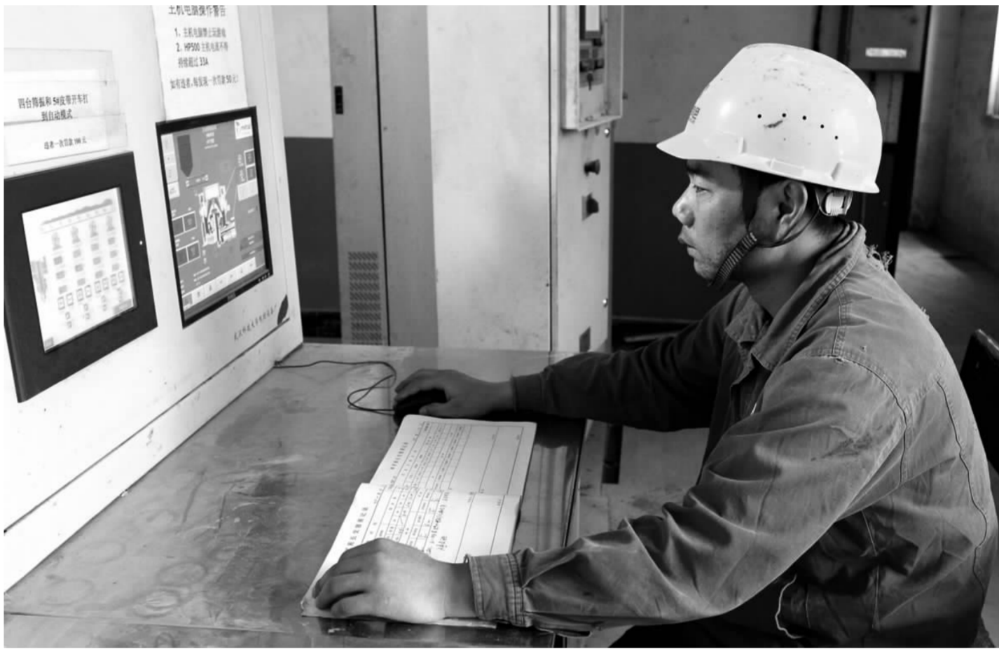
▲碎矿工段工作人员在操作变频器控制连锁装置。汪纯 摄
