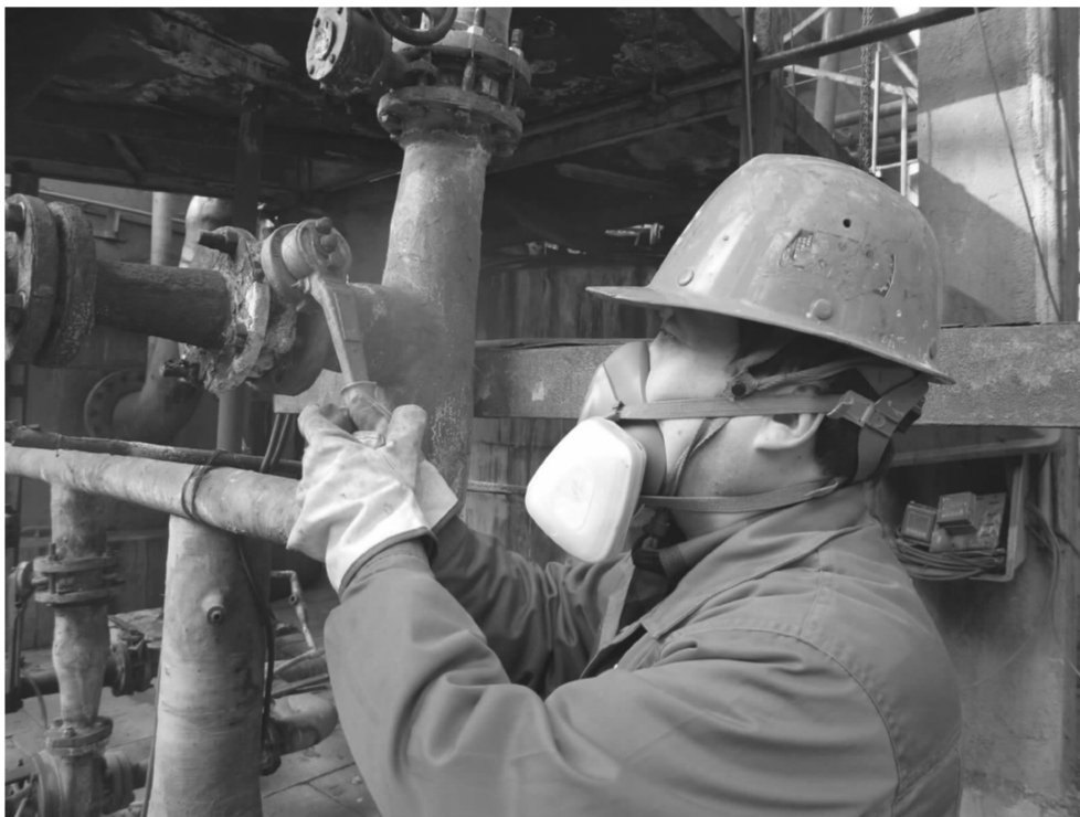
▲污酸硫化班职工在调节循环槽的进出口阀。黄红梅 摄
