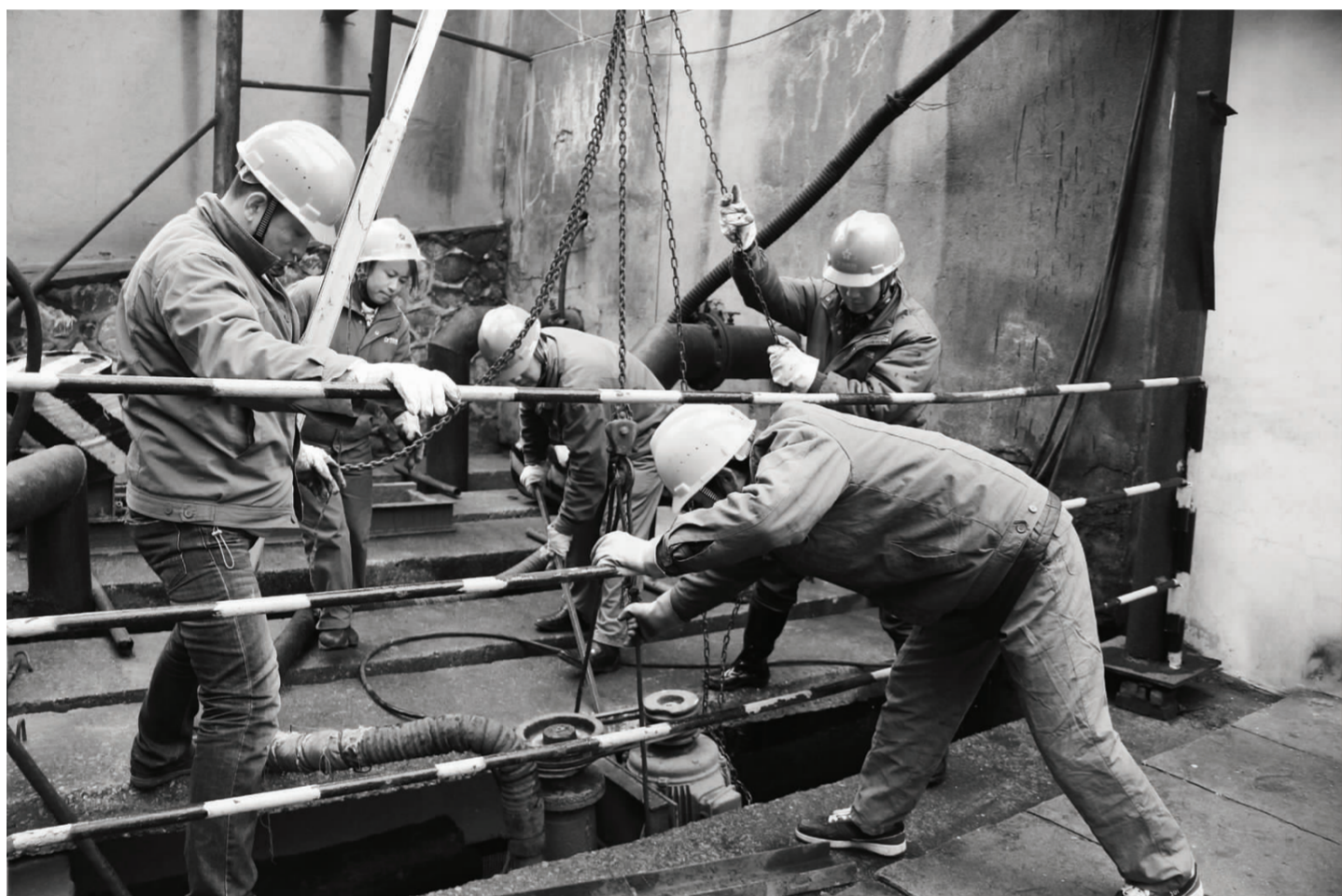
▲ 大家正在合力把砂泵往7号泵房沉淀池内吊放 梅晓艳 摄
