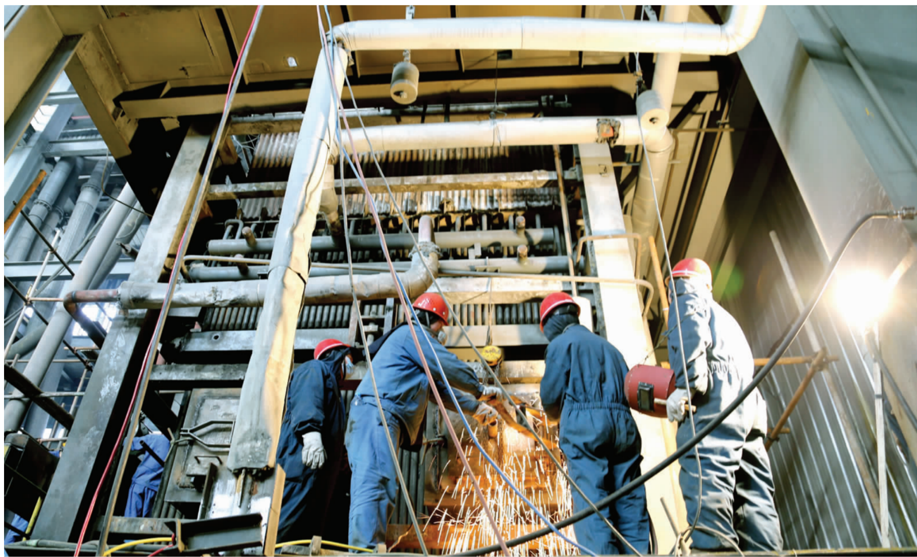
▲ 1 月 15 日,冶炼厂澳炉系统检修施工人员正在焊接电炉配套装置 张国平 摄
