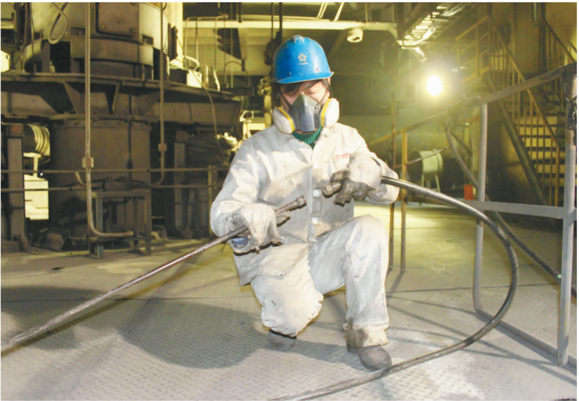
▲职工正在用金属软管连接风管 刘欣杰 摄
