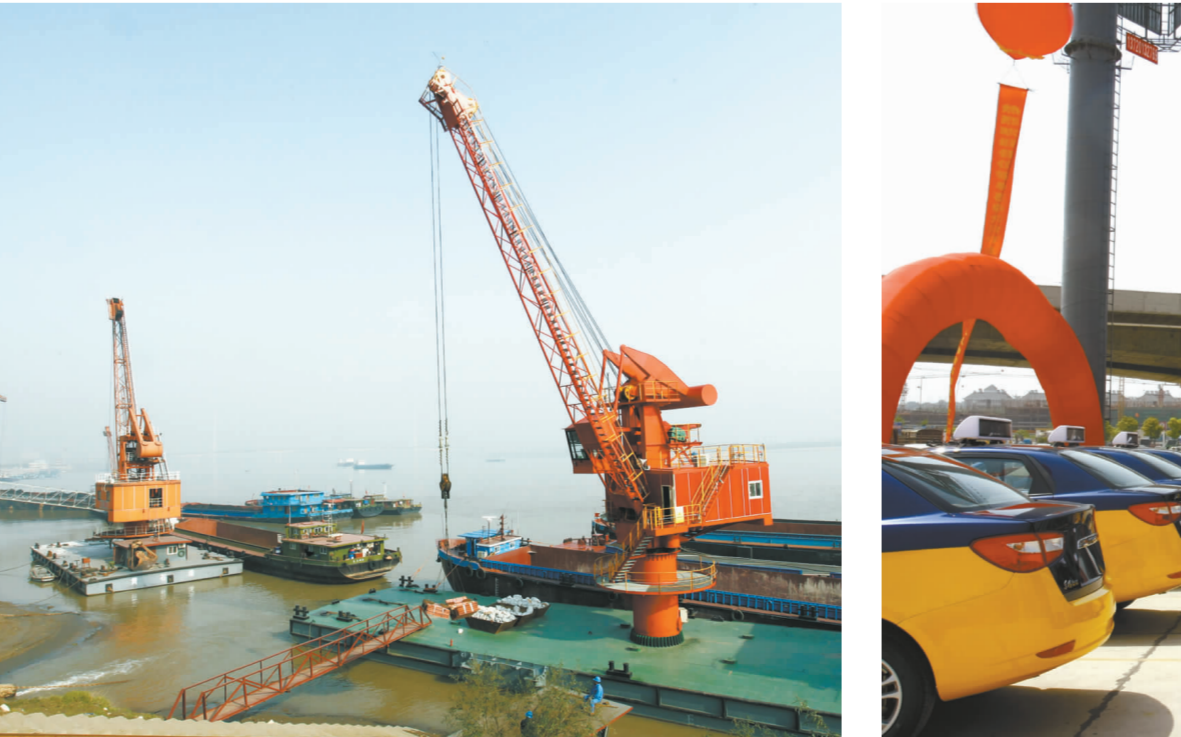
▼ 改造后的新码头
