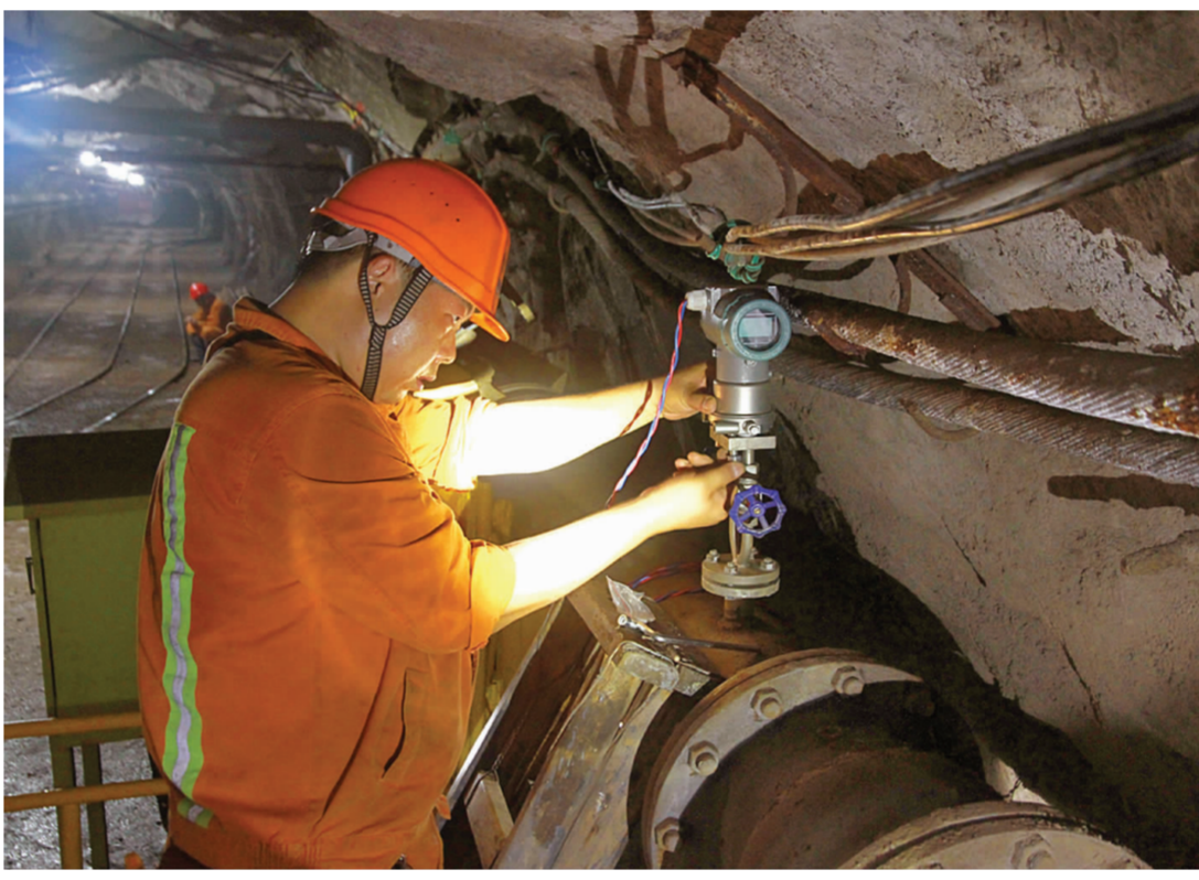
▲机运车间维修人员安装风流量计 陶坤 摄
