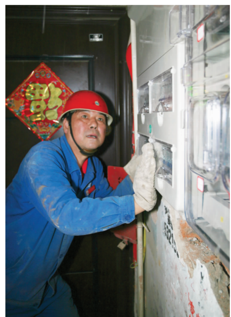
▲校正电表箱水平
