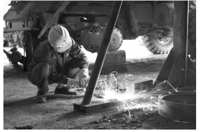
▲10月17日,为保证大车出勤率,铜山口矿机修车间维修二工段维修工加紧对大车故障进行检修维修,为全年生产任务的完成助力。 汪纯 摄
