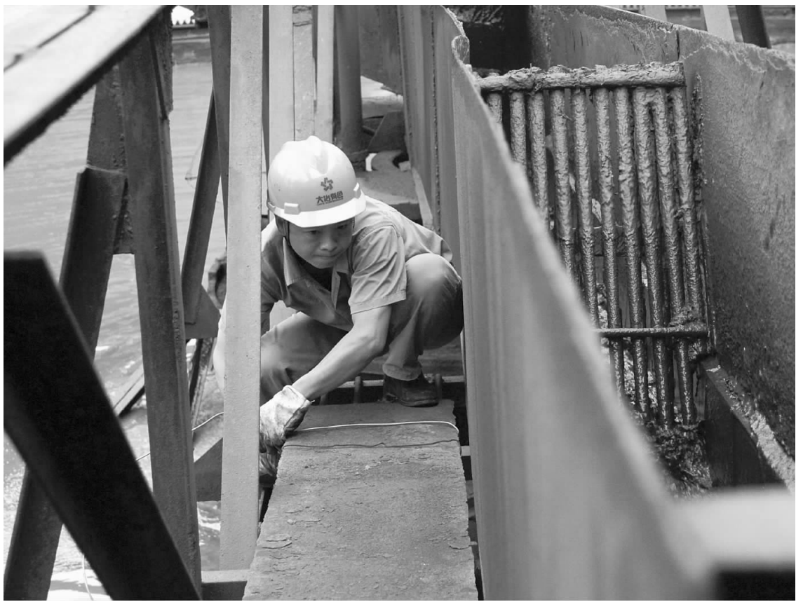
▲图为脱水工段职工将改造好的盖板铺设在进料槽钢筋上 方园 摄
