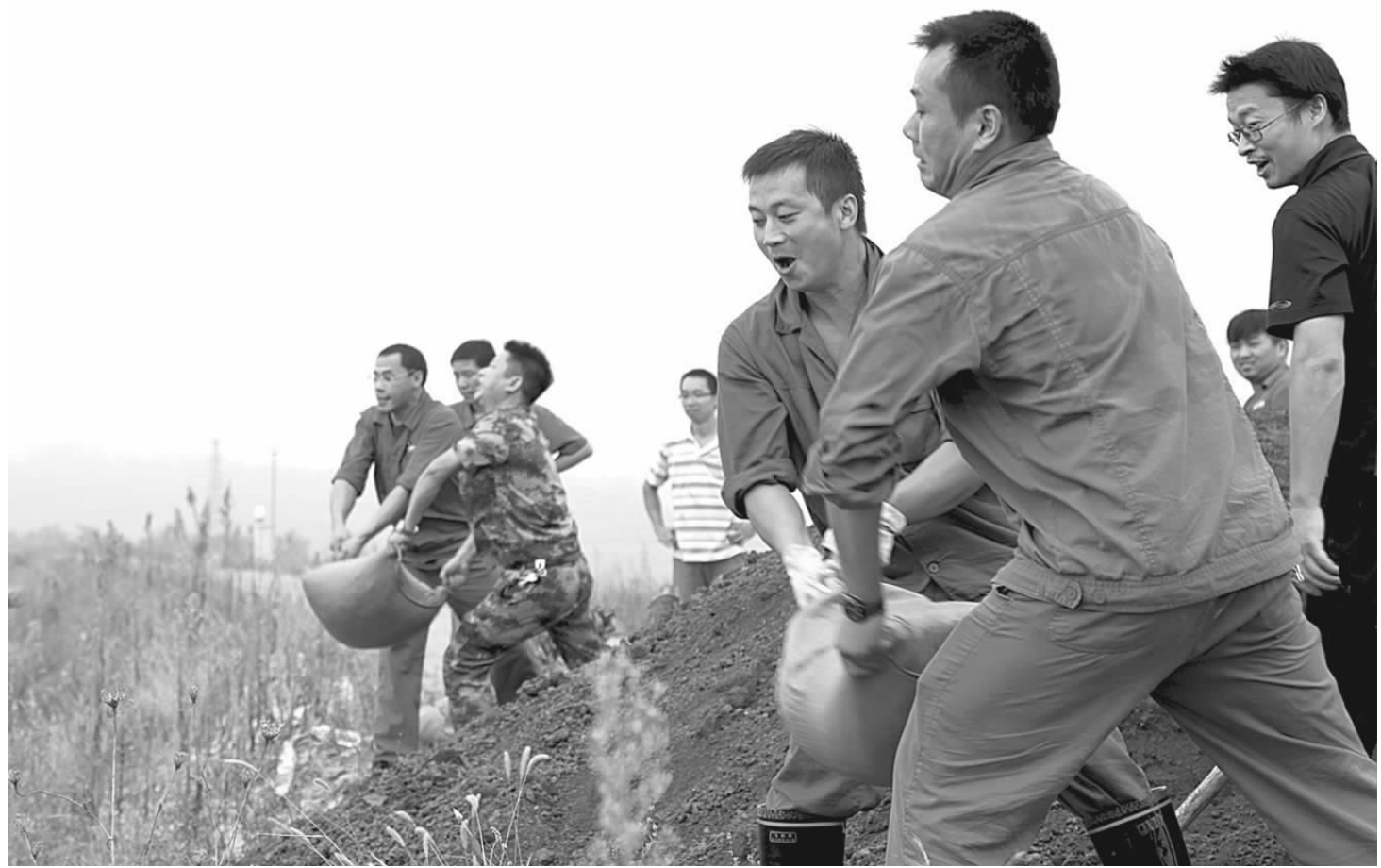
▲ 图为选矿车间防汛突击队奋战在尾矿库防汛现场 张琳 摄
