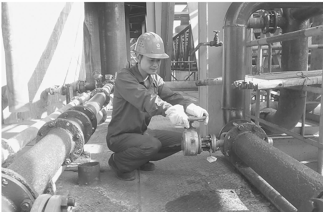
▲图为该工段职工正在开冲洗水管阀门准备进行电雾冲洗工作 居小斌 摄
