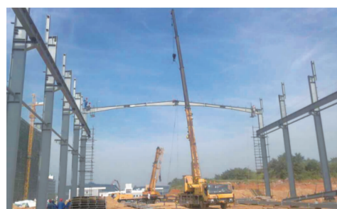
8月14日,瑞鑫铜业铜杆线车间第一根大梁成功吊装。(郑晓曼 彭伟胜)
