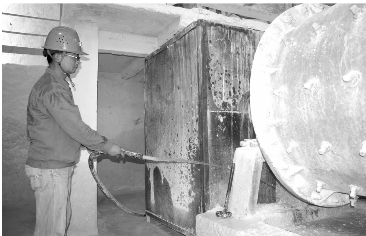
▲因为机电修造公司丰山项目部维修二班班长正在对石灰岗外密封罩进行冲洗 范勇摄
