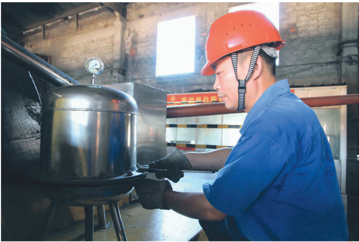
▲图为该工段职工正在监测自制压力缓冲器上的压力表值 方圆 摄
