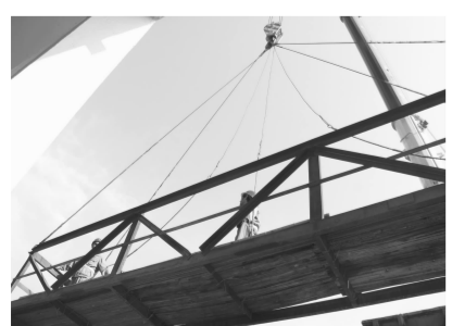
▲7月19日,建安公司创新自制的“大吊篮”高空作业施工法投入使用后,短短半天时间就完成了硫酸镍厂房的两跨墙面檩条安装任务,相比过去需3天的工期,在降低安全风险的同时大大提高了生产效率。程玲 摄
