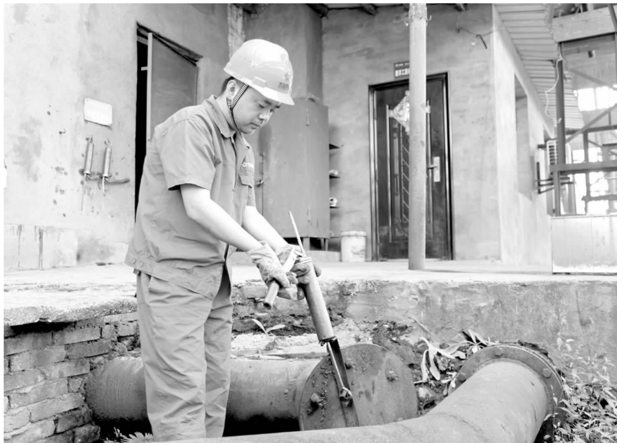
▲图为该班职工正在利用油枪拉力器为油枪加油 张琳 摄
