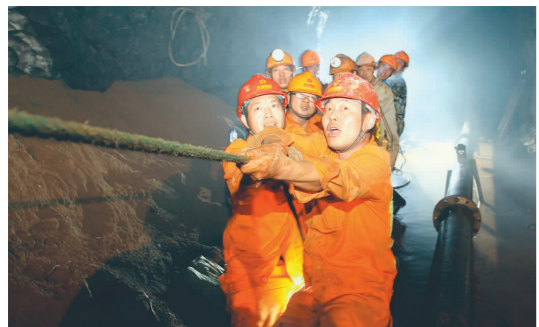
▲7月13日,铜绿山矿三友公司组织有关人员井下排水设备进行安装。该公司在采掘工程施工前认真分析水情,制订探放水措施,确保井下平安度汛。 周志刚 摄
