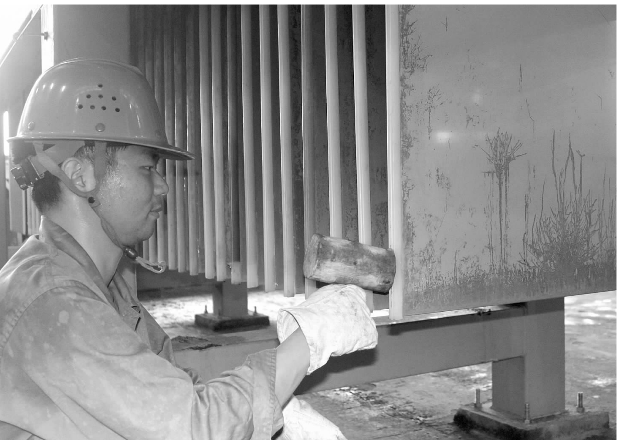
▲ 图为该车间职工正在剥片机组排板架作业现场,紧固不锈钢阴极板夹边条。 魏马亮 摄
