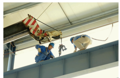
▲由建安公司承担的物流园项目建设又有新进展。从6月18日进驻现场进行轨道、消防管道等安装施工以来,该公司严格执行“工有交底、安全有保障、现场有监管”的原则,面对高温灵活调整施工节奏,保证施工进度,仅用3天时间就完成了流通车间的轨道铺设施工任务。罗志斌 摄
