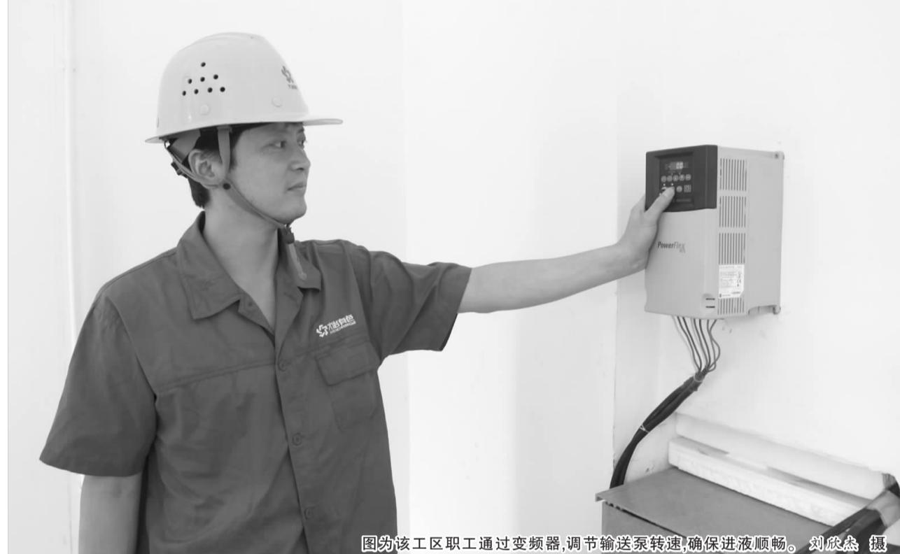
图为该工区职工通过变频器,调节输送泵转速,确保进液顺畅。刘欣杰 摄
