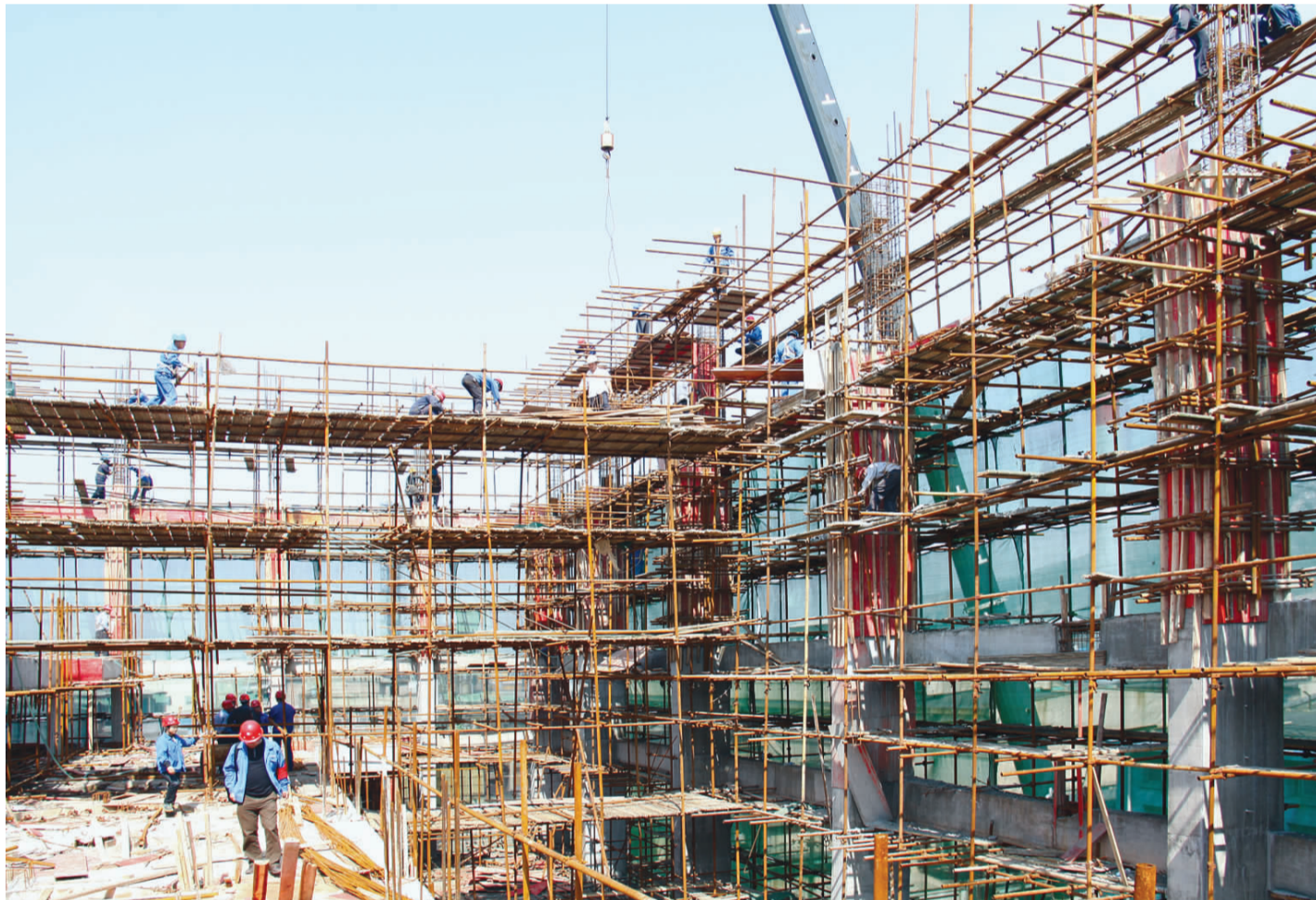
五一期间,硫酸镍厂房26.1米处连系梁施工现场。程玲 摄
