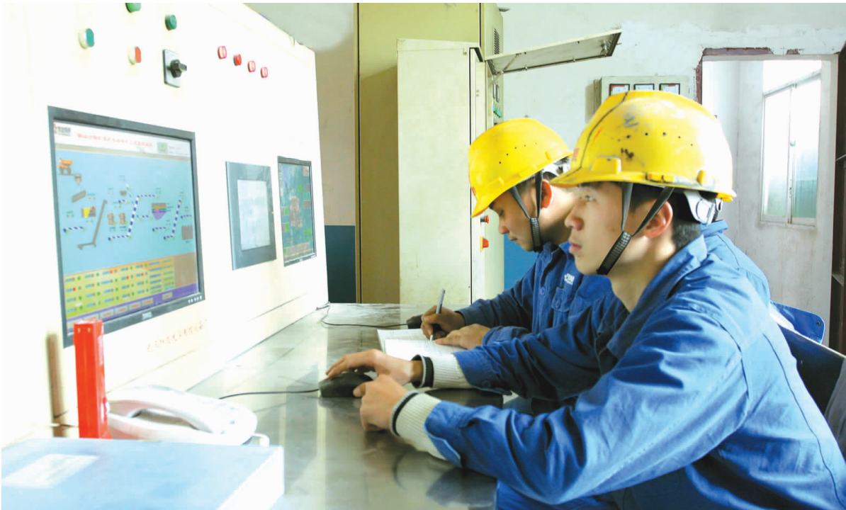
图为春节期间铜山口矿选矿车间碎矿工段职工在精心操作。(程小燕 摄)
