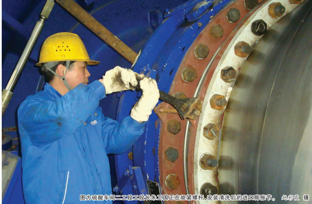
图为硫酸车间二工段工段长朱卫国正在旋紧螺杆,安装清洗后的进回膨胀节。赵彩霞 摄
