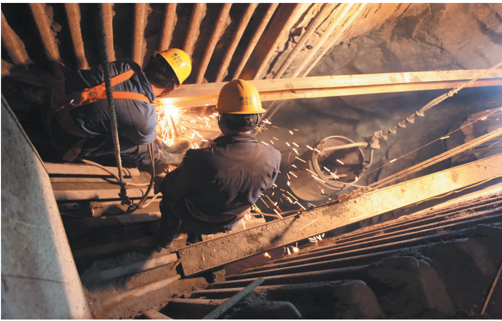
元旦 3 日,井巷有限公司全面启动铜绿山矿矿仓加固工程,图为施工人员进行为给矿仓实施“外科手术”。(郭小勇 叶圣华 摄)
