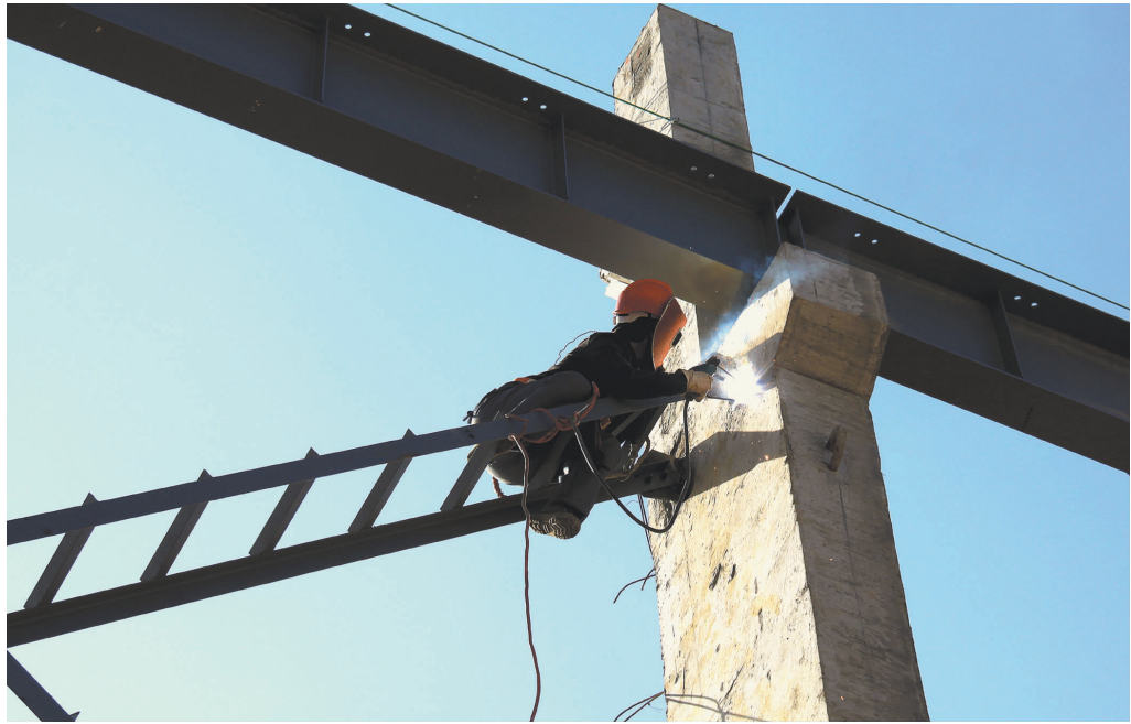
元旦 1 日,建安钢构公司职工战斗在三九严寒的户外高空,进行着稀贵园项目二期建设焙烧厂房的钢架系统的安装施工中。(程玲 摄)
