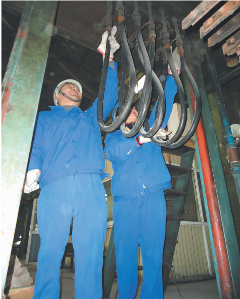
元旦 1 日,金禾公司两名职工正在为 2 号上引炉检修。(蔡华斌 摄)
