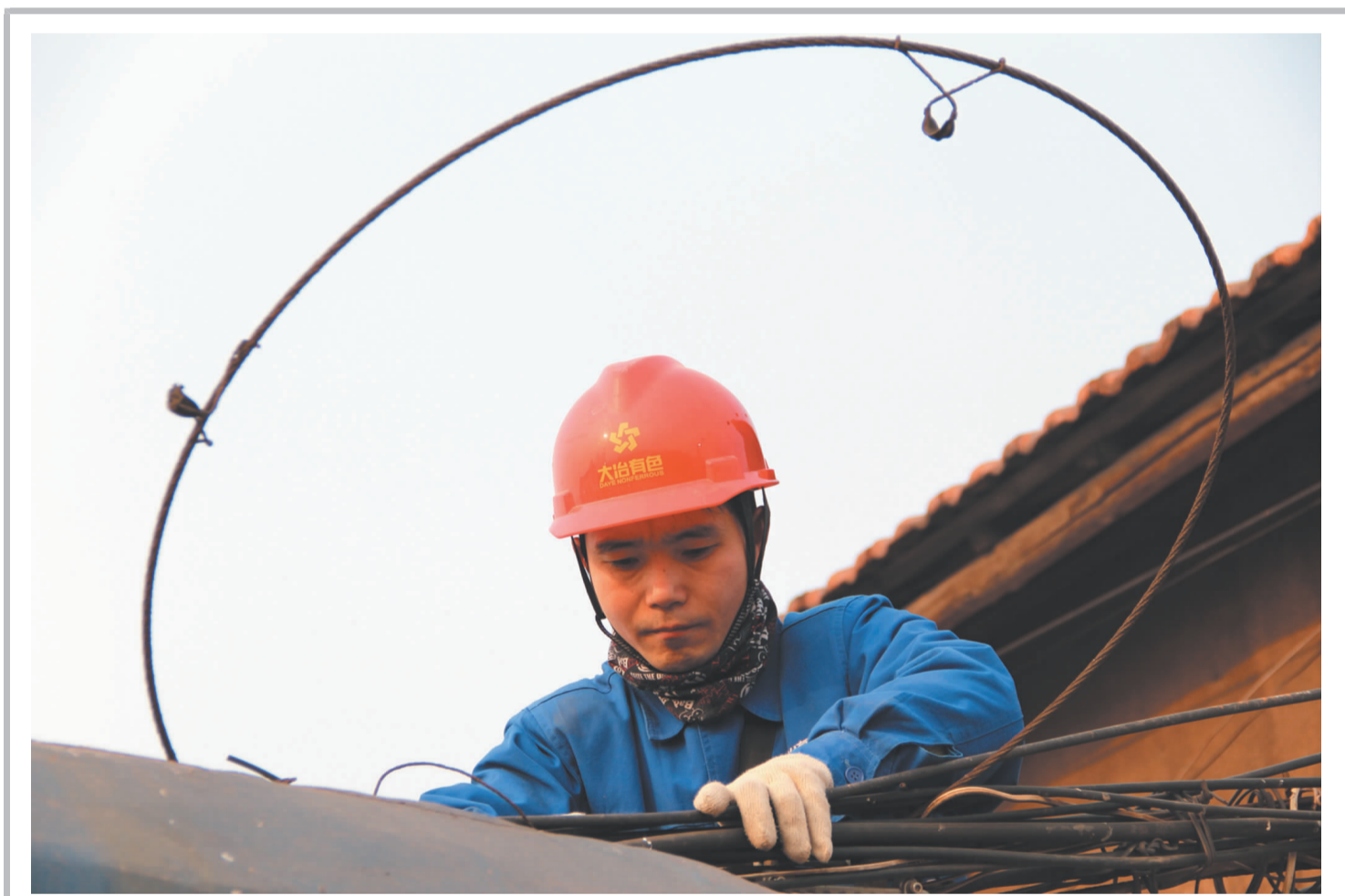
集团公司第一次党代会提出,要坚持以人为本,实现共建共享,打造和谐有色。铜绿山矿按照公司“大福利”理念,坚持为职工办实事,为89户新搬迁的棚户区、黄梅村拆迁户和大学生公寓安装有线电视,满足职工群众的文化娱乐需求。图为1月8日,该矿电视台和水电车间人员在现场进行紧张施工。(柯志鹏 梅晓艳 摄)
