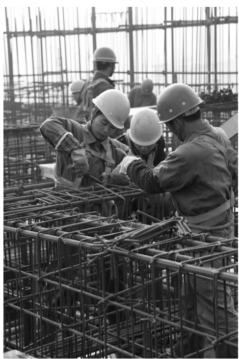
建安公司快马加鞭搞好矿山工程建设,继铜山口深部开采工程副井井塔桩基施工节点目标实现后,11月20日,该工程10米平台近230平方米的钢筋施工正在紧张进行中。(程玲 摄)
