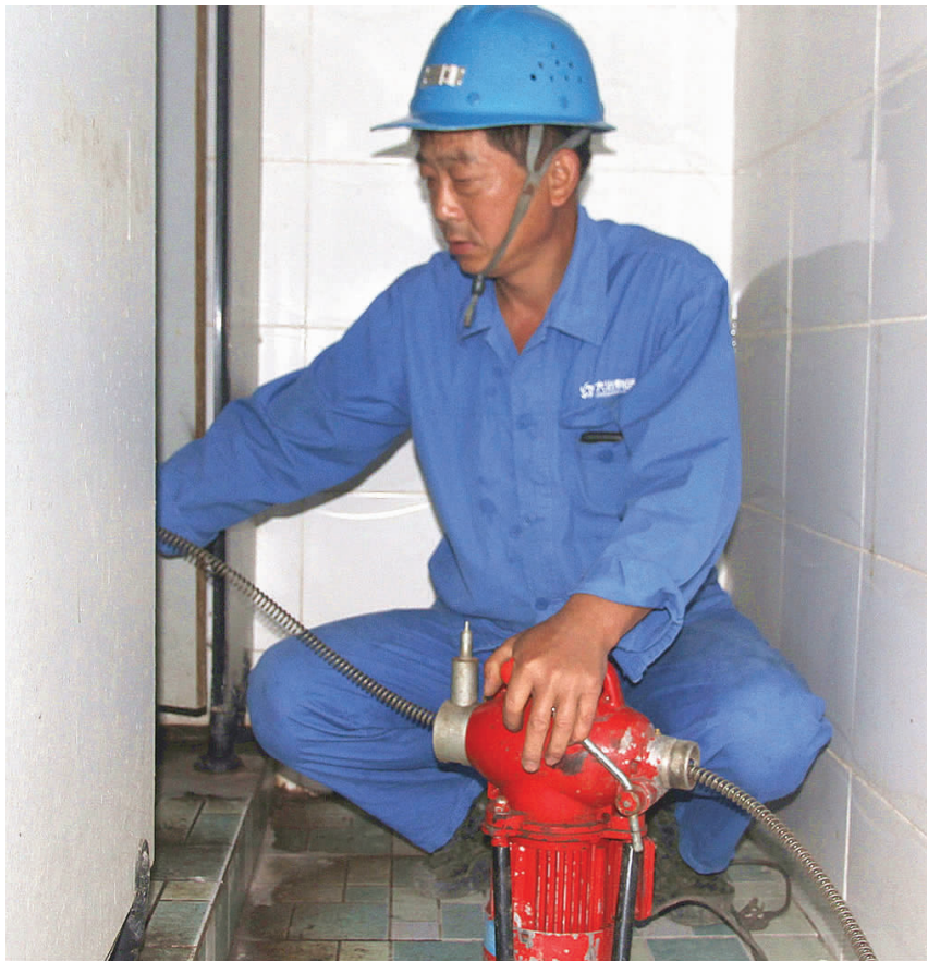
图为周国明正在疏通下水道 占亚芬 摄
