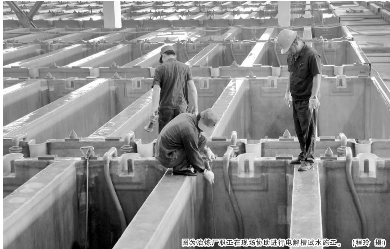
图为冶炼厂职工在现场协助进行电解槽试水施工。(程玲 摄)
