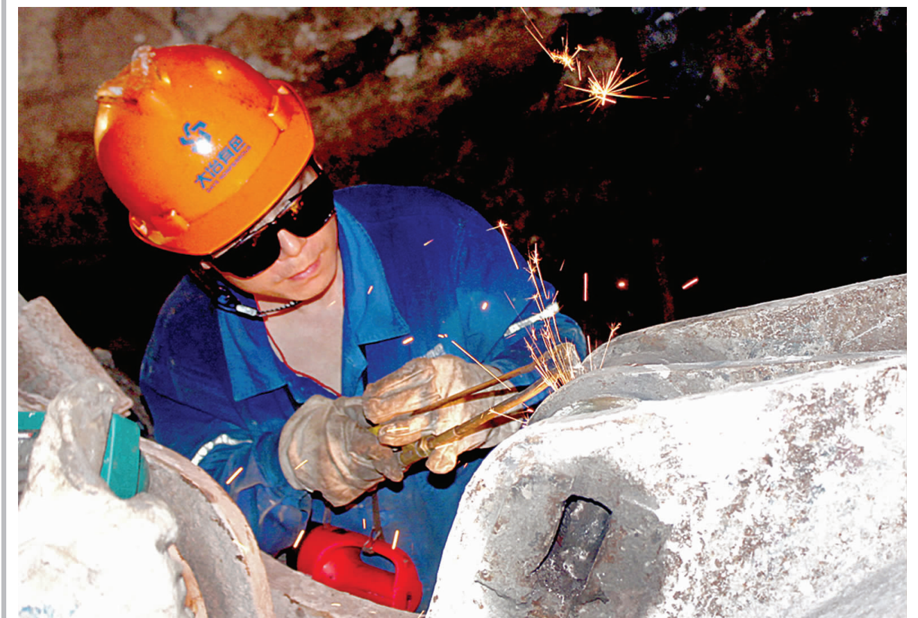
为加快井下铲矿速度,提高铲运机台班功效,铜绿山矿坑采车间实行铲运机维修工跟班作业,及时解决铲运机临时故障。图为8月2日,该车间采二工段维修工在井下现场抢修铲运机。(柯善武 摄)
