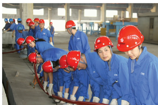
建安公司机关干部职工集结30万吨施工现场,为该工程敷设电缆。(王军 摄)
