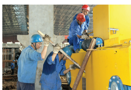
建安公司与多方协作,确保30万吨项目芬兰产主行车顺利吊装。(程玲 摄)
