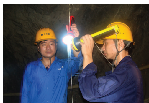
井巷公司两名工程技术人员,在铜绿山矿新副井井下-485米中段进行巷道定向测量作业。(叶圣华 摄)
