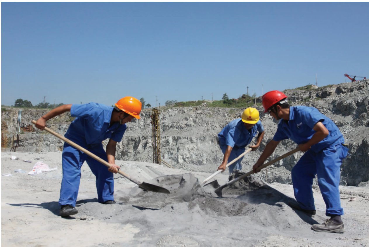
爆破工正在高温下进行填装作业 胡少俊 摄
