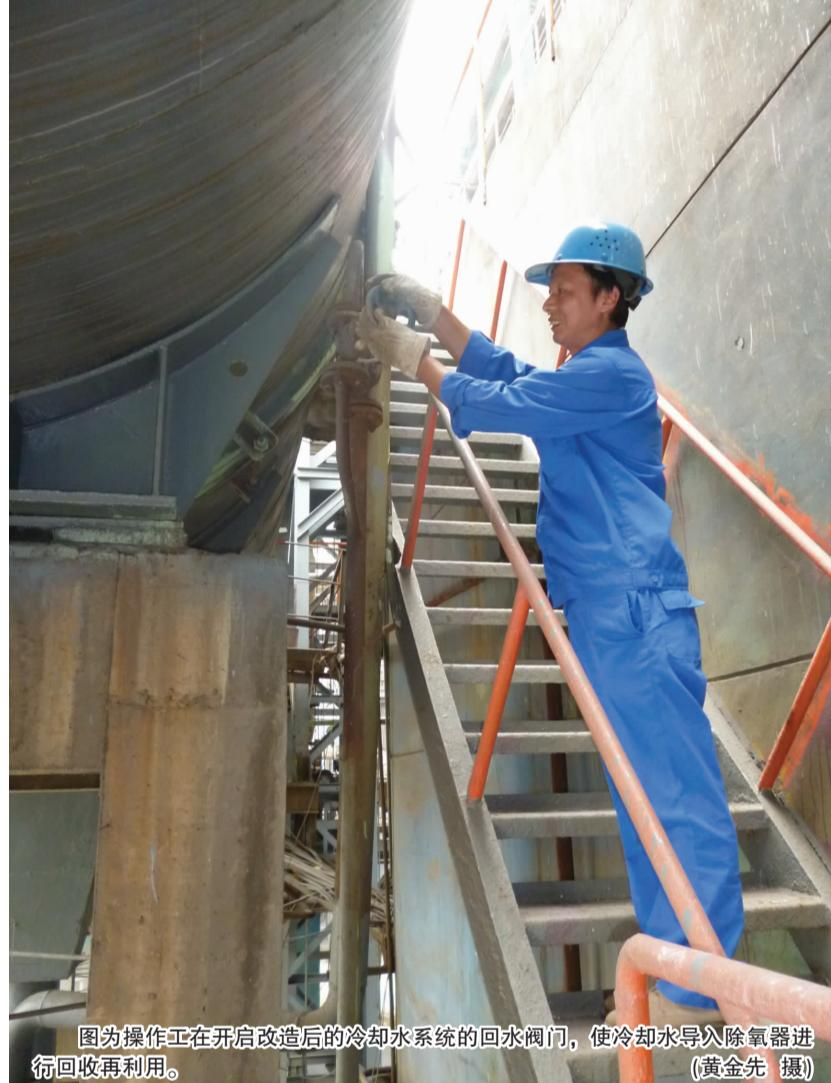
图为操作工在开启改造后的冷却水系统的回水阀门,使冷却水导入除氧器进行回收再利用。(黄金先 摄)
