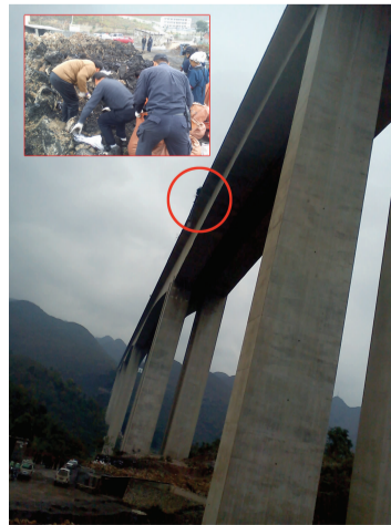
2011年12月13日,内保中心押运队员正在赴某省押运阳极泥归途中的事故现场抢救阳极泥。(柳佳祥 摄)
