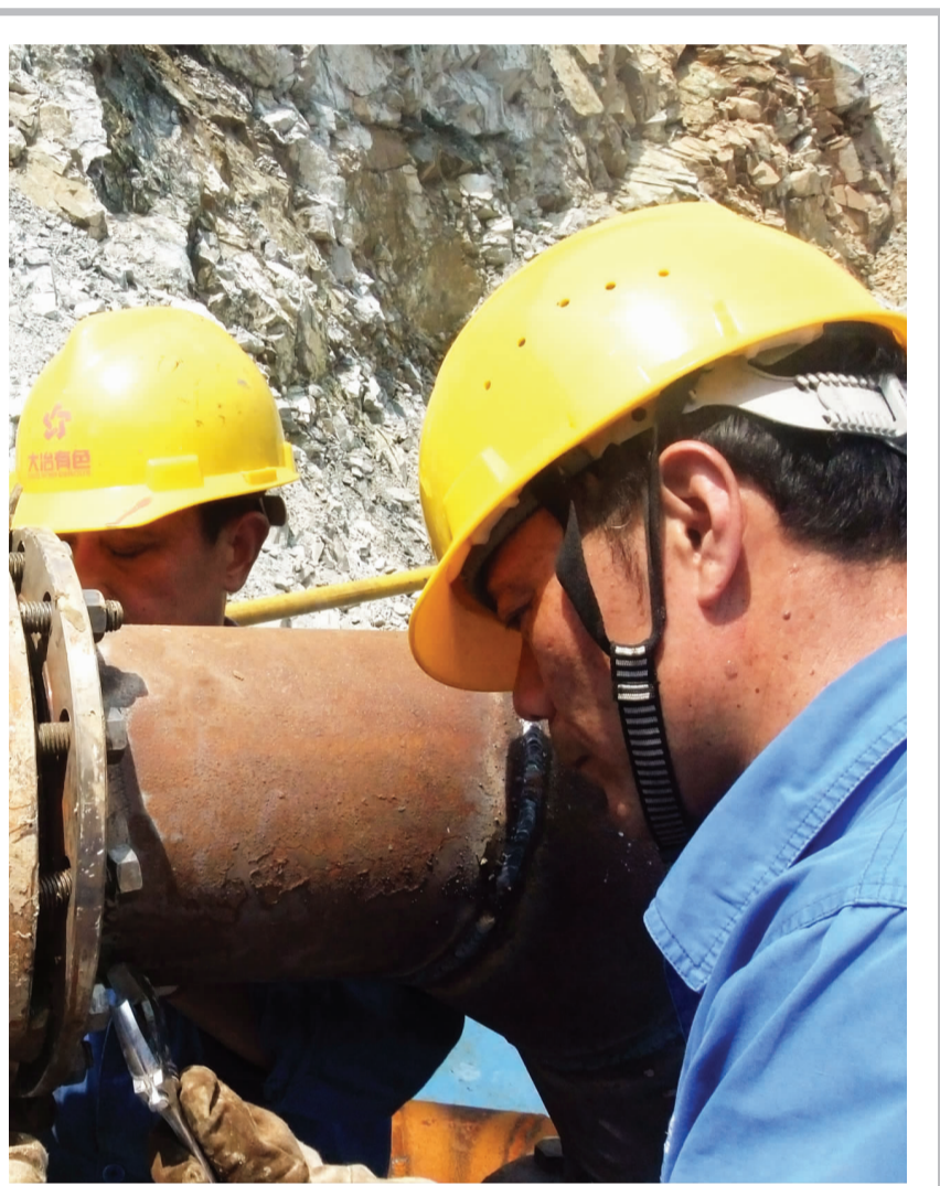
5月15日,铜山口矿机电修造公司提前3天完成该矿露天车间浮船防汛管道的对接安装工作,确保了采场排洪顺畅。图为职工正在安装浮船防汛管道。(方磊 摄)
