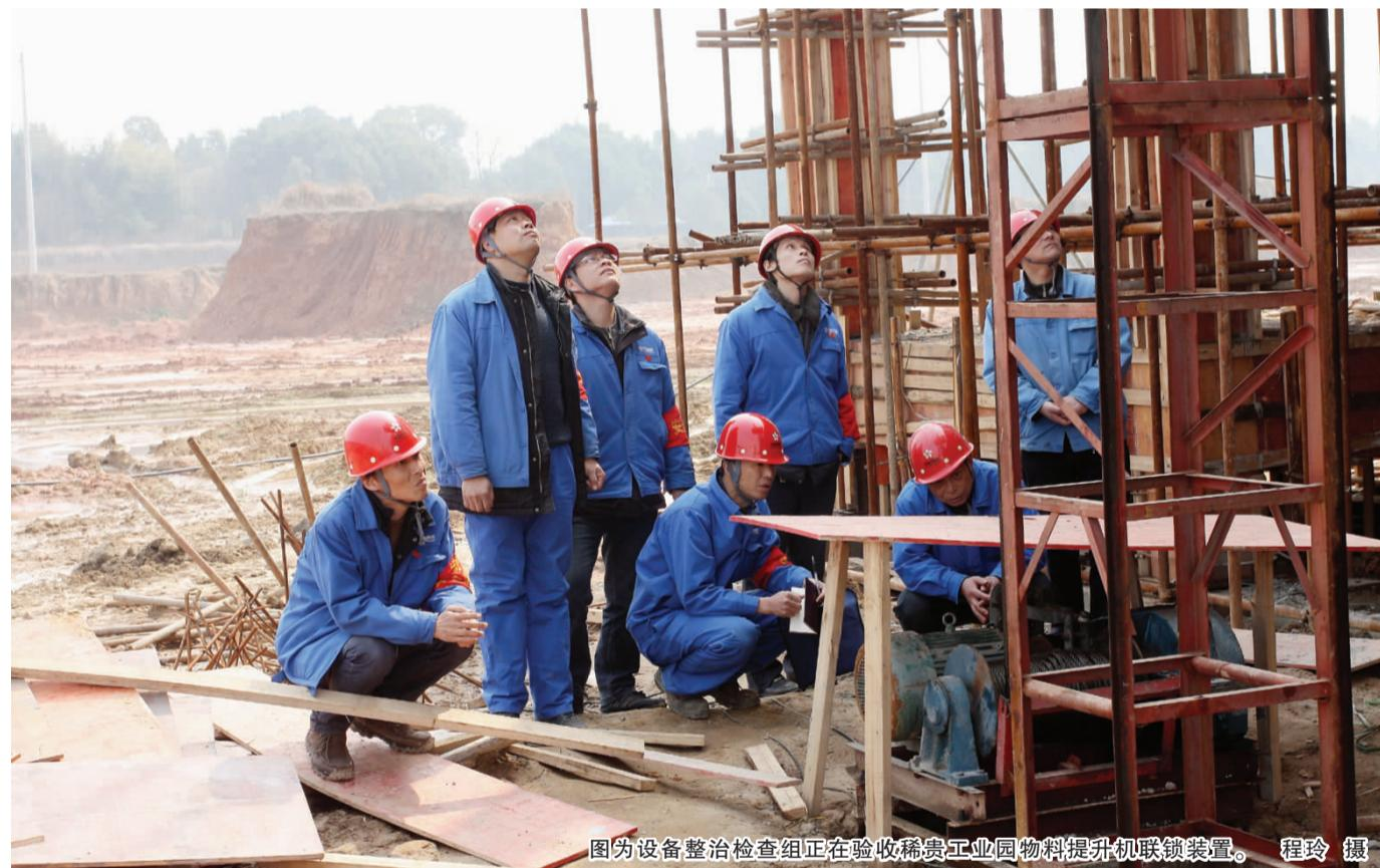
图为设备整治检查组正在验收稀贵工业园物料提升机联锁装置。程玲 摄
