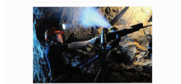
2月25日,工人在大冶有色集团铜绿山矿海拔425米中段8415采场工作。近年来,湖北大冶有色集团铜绿山矿坚持走可持续发展之路,节约集约合理开发矿产资源。目前,该矿于2009年新开工的铜绿山矿XI号矿体开采工程已掘进到负635米,预计2014年建成投产。该工程可新增众多资源储量,延长矿山服务年限13年。铜绿山矿开采的历史久远,由于长期开采,当地已探明矿石储量渐渐无法满足生产正常需要。为此,大冶有色集团铜绿山矿积极探索深层探矿技术,寻找新的矿源,满足正常采掘的需要。通稿是以组照的形式编发,作者杜华举是新华社高级记者,新华社湖北分社图片总监,湖北省摄影家协会副主席。杜华举此次是为公司通讯员培训班讲学而来的,在三天时间里,他专程赶往铜绿山矿井下采访,并被公司“十一五”期间的快速发展及铜绿山矿这座“焕发青春”的老矿所感动。
