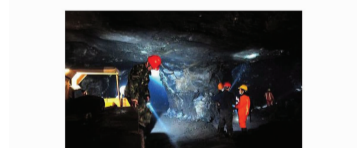
2月25日,工人在大冶有色集团铜绿山矿海拔425米中段8415采场工作。近年来,湖北大冶有色集团铜绿山矿坚持走可持续发展之路,节约集约合理开发矿产资源。目前,该矿于2009年新开工的铜绿山矿XI号矿体开采工程已掘进到负635米,预计2014年建成投产。该工程可新增众多资源储量,延长矿山服务年限13年。铜绿山矿开采的历史久远,由于长期开采,当地已探明矿石储量渐渐无法满足生产正常需要。为此,大冶有色集团铜绿山矿积极探索深层探矿技术,寻找新的矿源,满足正常采掘的需要。通稿是以组照的形式编发,作者杜华举是新华社高级记者,新华社湖北分社图片总监,湖北省摄影家协会副主席。杜华举此次是为公司通讯员培训班讲学而来的,在三天时间里,他专程赶往铜绿山矿井下采访,并被公司“十一五”期间的快速发展及铜绿山矿这座“焕发青春”的老矿所感动。
