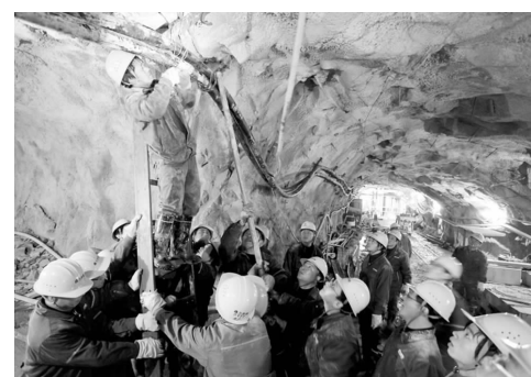
2月1日,井巷公司组织机关党员干部到铜绿山矿井下负725米中段架设水泵动力电缆。图为该公司机关党员干部在井下架设动力电缆的情景。(郭小勇 叶圣华 摄)
