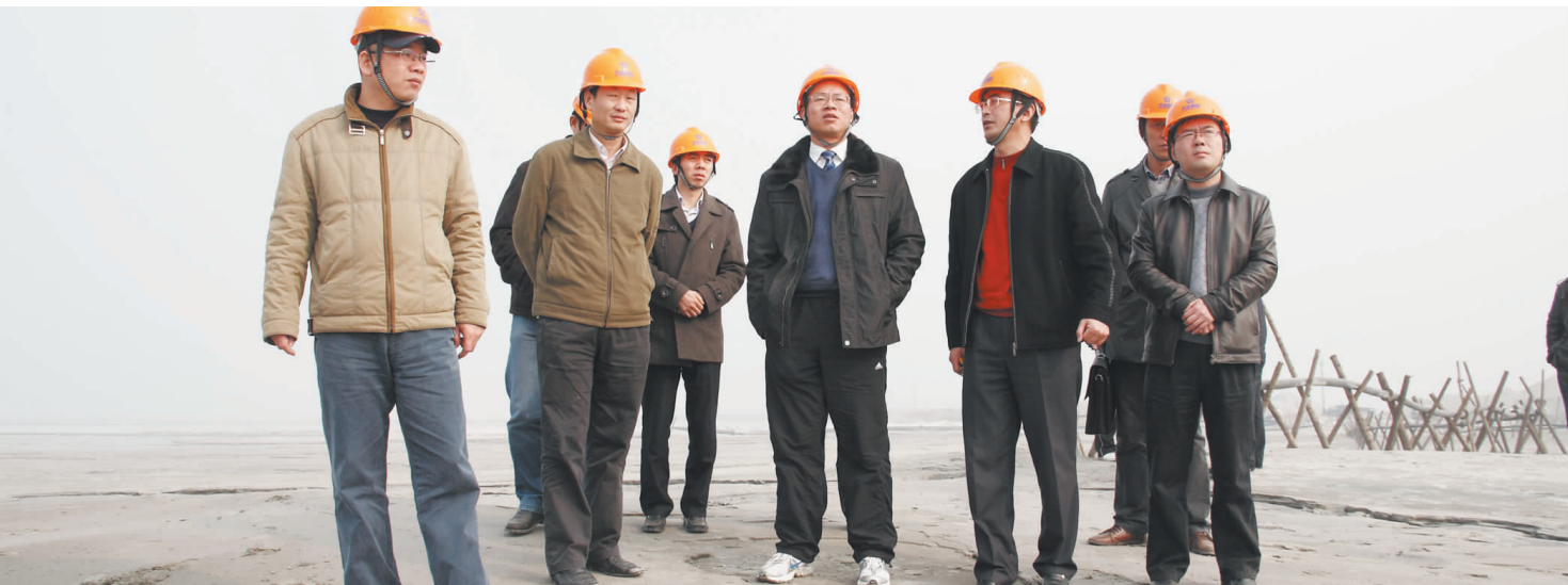
■ 上图 张麟在澳炉检修现场 邱杰 摄
