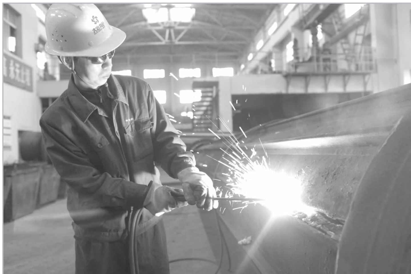
稀贵厂针对今年生产任务的完成情况和主要生产设备回转窑的使用状况,合理组织检修设备工作,以促进生产任务的顺利进行。图为12月26日,稀贵厂维修人员正对该厂一车间的2号回转窑的主体进行切割作业。(叶志海 摄)
