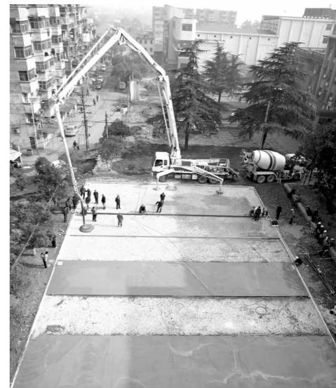
11月26日,铜绿山矿门前广场工程完成场地平整工作,将进入设施修建阶段,集矿山形象展示、职工休闲娱乐于一体的标志性景观地块雏形初现。据初步预计,此项工程将于春节前基本完工。(秦雷 摄)
