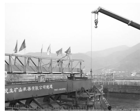
11月中旬,铜山口矿30米浓密机大架出现倾斜、变形,需要停车进行为期十余天的检修。在此阶段,该矿一方面用组织好正常生产,另一方面积极组织维修人员做好浓密机的检修工作。图为浓密机检修现场。(杨继成 摄)
