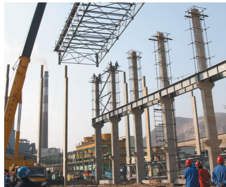
11月23日,公司30万吨铜加工生产清洁示范项目现场,大型运输、起重设备分工协作,厂房屋盖系统第一根跨度为33米、重量为17吨的的钢屋架稳当就位,标志着该工程钢屋架进入全面吊装阶段。(程玲 摄)
