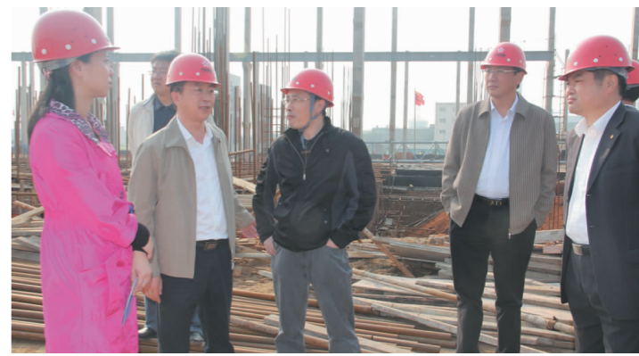
11月14日,下陆区委书记、区长等领导在有限公司副总经理廖全佳的陪同下,到30万吨铜电解项目工程视察,了解工程进度情况。(张勇 摄)
