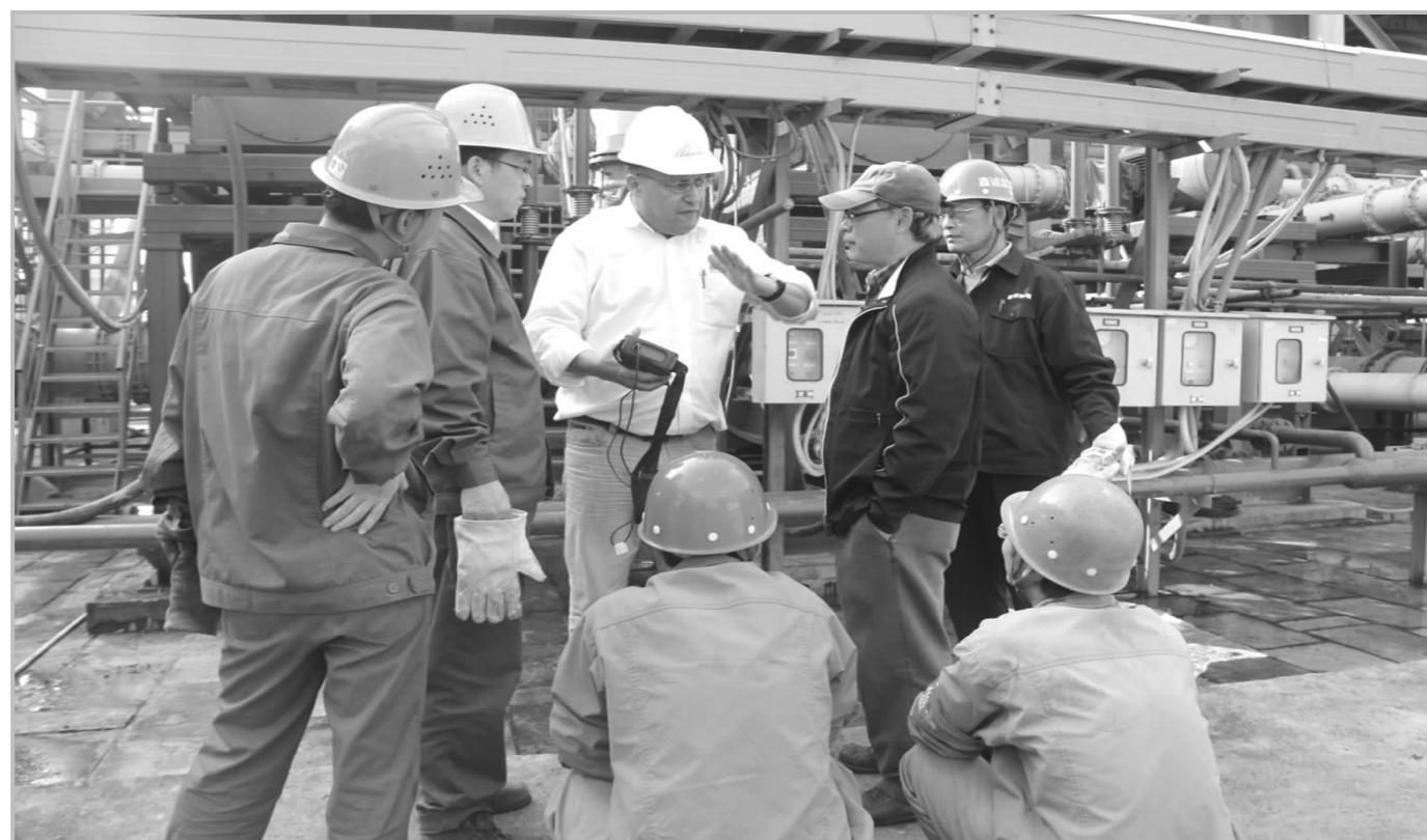
硫酸三系异地改造工程自9月份通气生产以来,冶炼厂始终关注工程进度,及时解决设备出现的各种问题。图为11月3日,该厂硫酸车间技术、维修人员与建安公司工程技术人员一道,在澳大利亚专家的指导下,现场处理净化系统二级动力波泵振动的问题。
