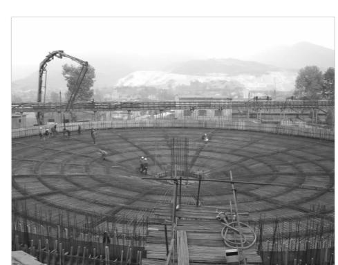
11月4日午时1点,经过建安华建公司24小时的连续奋战,铜山口2号浓密池底板760立方米混凝土浇筑施工完毕,这标志着该矿浓密池工程初步具备安装施工条件。
