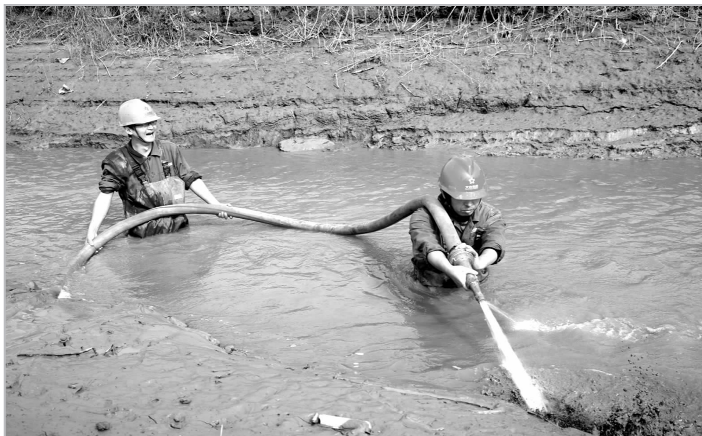
受大冶湖外湖水质因素的影响,大量泥沙淤积在铜绿山矿外湖泵房进水港港口,导致河道堵塞,直接影响到该矿生产用水的供应。紧要关头,该矿水电车间组织突击队进行河道清理,经过4小时的奋战,顺利完成清理任务。图为11月1日,该车间两名突击队队员正在进行河道清理。(秦霄 李细柱 摄)
