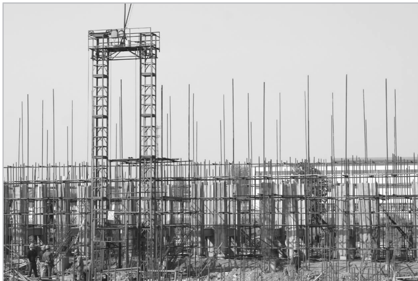
10月19日,稀贵工业园的施工建设正在热火朝天地进行之中。自开工以来,稀贵工业园的项目建设一直在紧张进行,截至目前,稀贵园区的三通一平和土地平整后的测量工作基本完成。主厂房施工方面,溶液处理厂房正在进行地面施工建设,浸出厂房已完成地下承台建设,转炉厂房正在进行钢结构吊装,金银精炼、铂钯厂房完成了基础土方施工。接下来,项目将进入辅助设施的施工阶段。图为溶液处理厂房施工现场。(陈红丹 摄)
