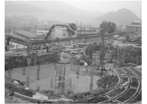
于今年6月15日开工的铜山矿两个直径45米浓密池及其配套工程进展顺利。目前,掘井、浇注柱基、铺设管道等地下基建工程均已完工,预计浓密池主体工程及加压泵房等配套设施建设均可在年内完工并交付使用。图为10月17日混凝土输送加压机正在进行筑底和水泥立柱浇注的工作情景。(陈玮玮 摄)
