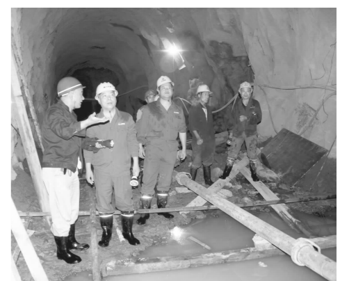
中秋小长假期间,井巷公司以加大领导下井带班力度为切入点,突出安全首位意识,全力拧紧节日生产施工“安全阀”。图为9月11日,该公司相关负责人在铜绿山矿负725M水仓工程施工现场了解安全生产动态。(叶圣华 摄)
